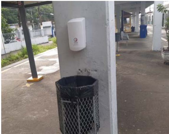
Figura 6-20 - Estação Belford Roxo - 17/10/2020
